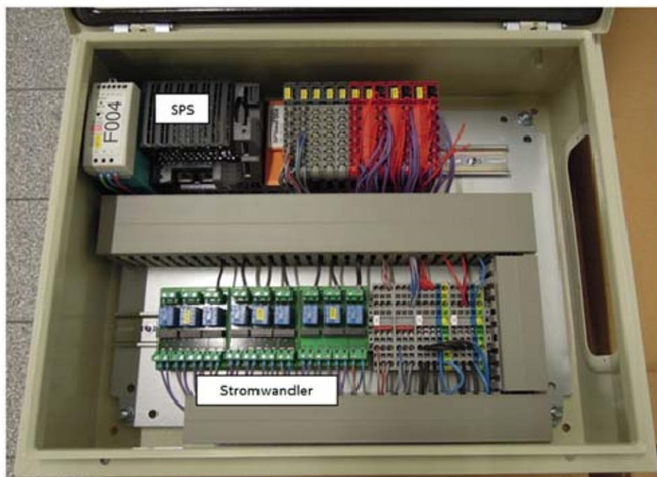
Abbildung 33: Schaltschrank der Messanlage F004\_2017\_SW
