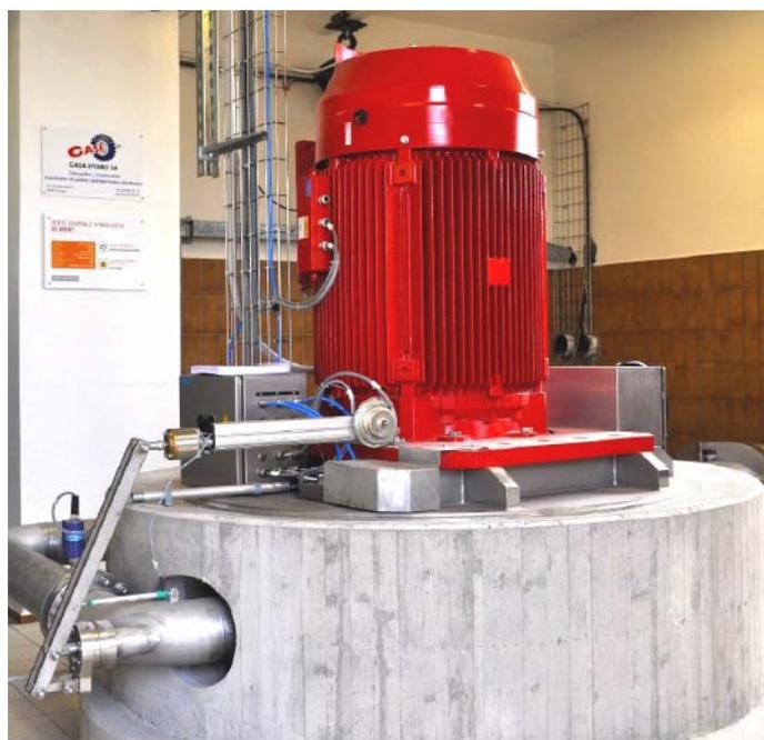
La nuova turbina Pelton della centrale Brent ( $Q = 84 \text{ l/s}$ ,  $H = 122 \text{ m}$ ,  $P_{el} = 80 \text{ kW}$ ,  $E_e = 380'000 \text{ kWh/a}$ ) (Foto: Romande Energie)
