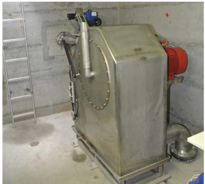
Turbine im Trinkwasser-Entleerungsschacht
