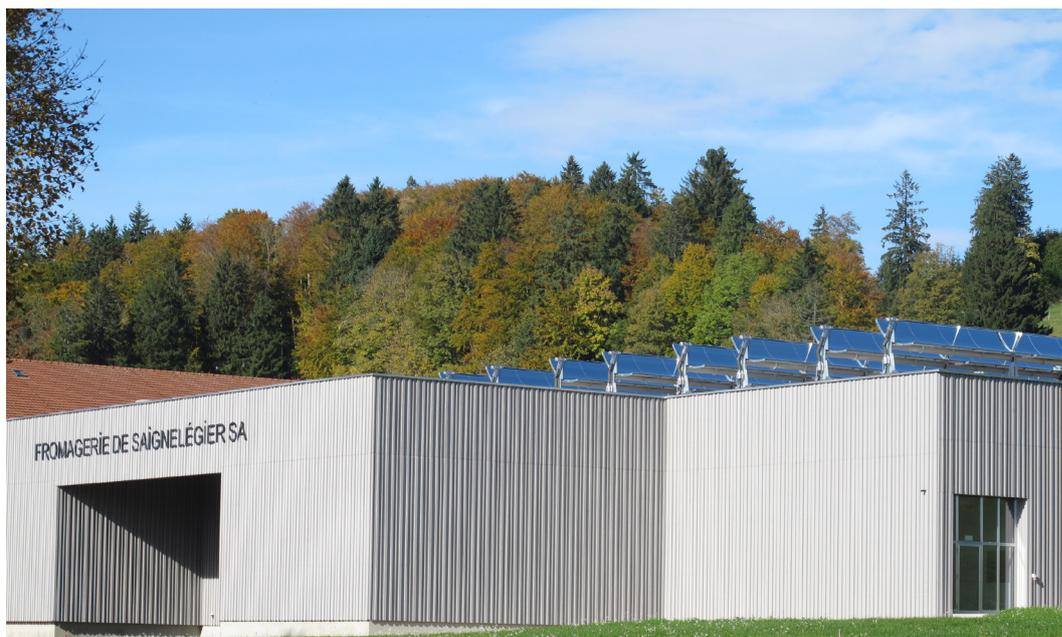
L'halle d'affinage de la Fromagerie de Saignelégier SA offrait un emplacement idéal pour le déploiement de 17 capteurs de type Poly Trough 1800. Photo: NEP Solar
