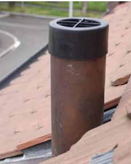
Heute verwendete Dunstrohre sind nicht isoliert, führen zu Wärmeverlusten und werden in den Normen energetisch noch nicht berücksichtigt.
