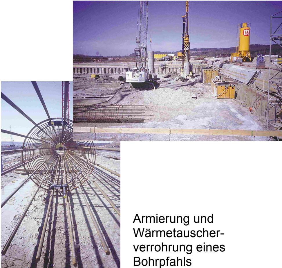
Armierung und Wärmetauscher-
