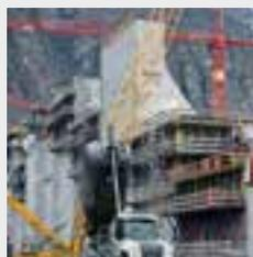
Le projet de centrale à pompage-turbinage «Linthal 2015» émane de la société Kraftwerke Linth-Limmern AG (KLL), une entreprise du canton de Glaris et de la firme Axpo. La nouvelle centrale, qui devrait afficher une puissance de 1000 mégawatts (MW) en pompage comme en turbinage, pompera l'eau du Limmernsee vers le Muttsee, situé 630 mètres plus haut. Ce projet
