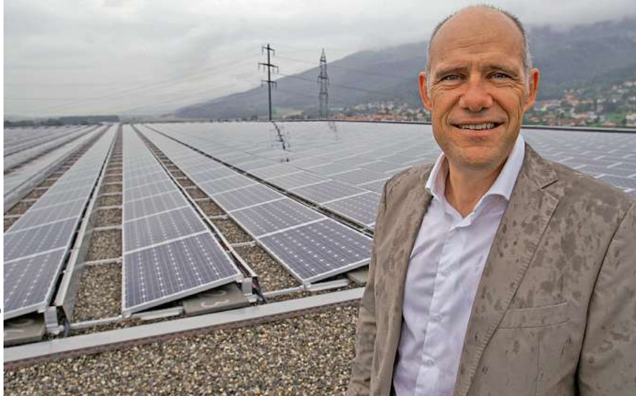
Norbert Ender, Leiter Smarter Cities bei IBM Schweiz und Ansprechpartner für das Projekt. Im Hintergrund die PV-Anlage auf dem Dach des Migros-Tiefkühlagers in Neuendorf. Die neu installierte PV-Anlage hat – wenn statt Regen die Sonne scheint – eine Leistung von 5,21 MWp und ist mit einem erwarteten Jahresertrag von 4,86 GWh die grösste Solarstromanlage landesweit.
