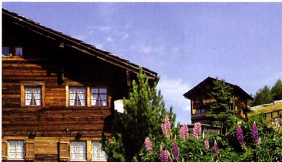
Nur zeitweise genutzte Liegenschaften bilden vor allem im Voralpen- und Alpengebiet eine Herausforderung für energie-effiziente Heizungs-lösungen. Bild EnergieSchweiz
