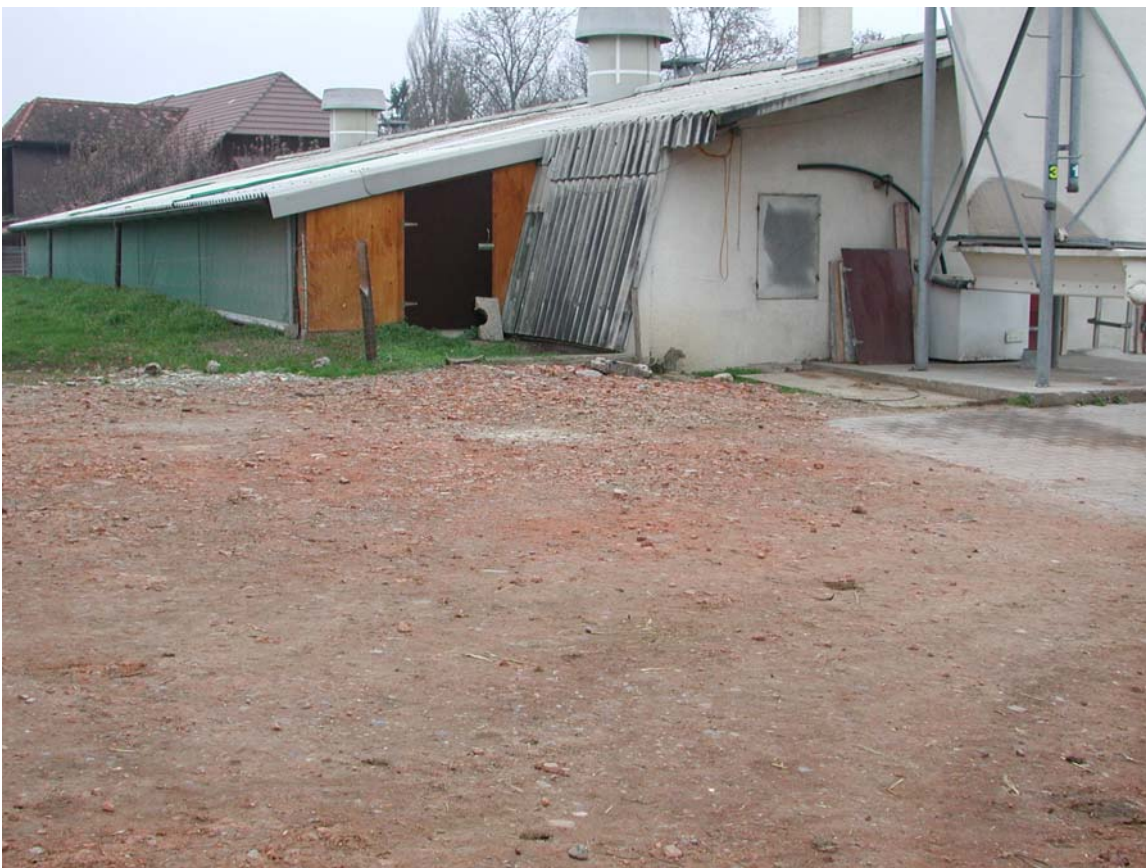
A 1.1 Standard Hühnerhalle à 5000 Hühner. Im vorderen Teil ist der Oelkessel untergebracht.
