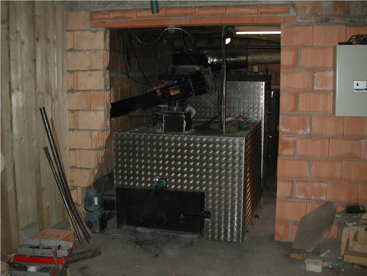
A 3.5.2.1.1. Der 2. Prototyp wurde in November 2001 installiert. Vorne die Feuerung, hinten der Wärmetauscher, seitlich das Sammelrohr mit Austragungsschnecke.
