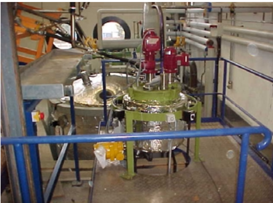
Fig 13: Installation d'imprégnation. Au premier plan le mélangeur dégasur.
