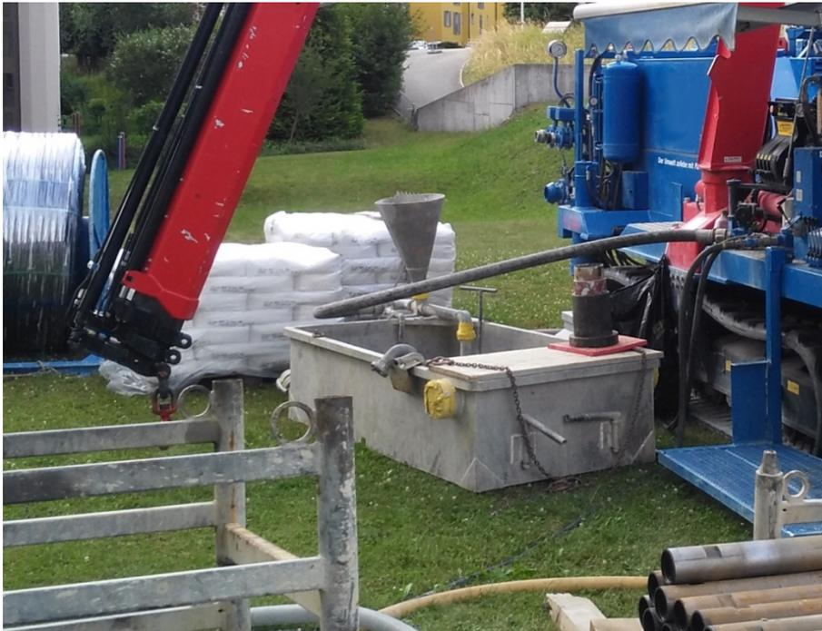
Fig. 4 vasca d'agitazione per miscelare la sospensione
