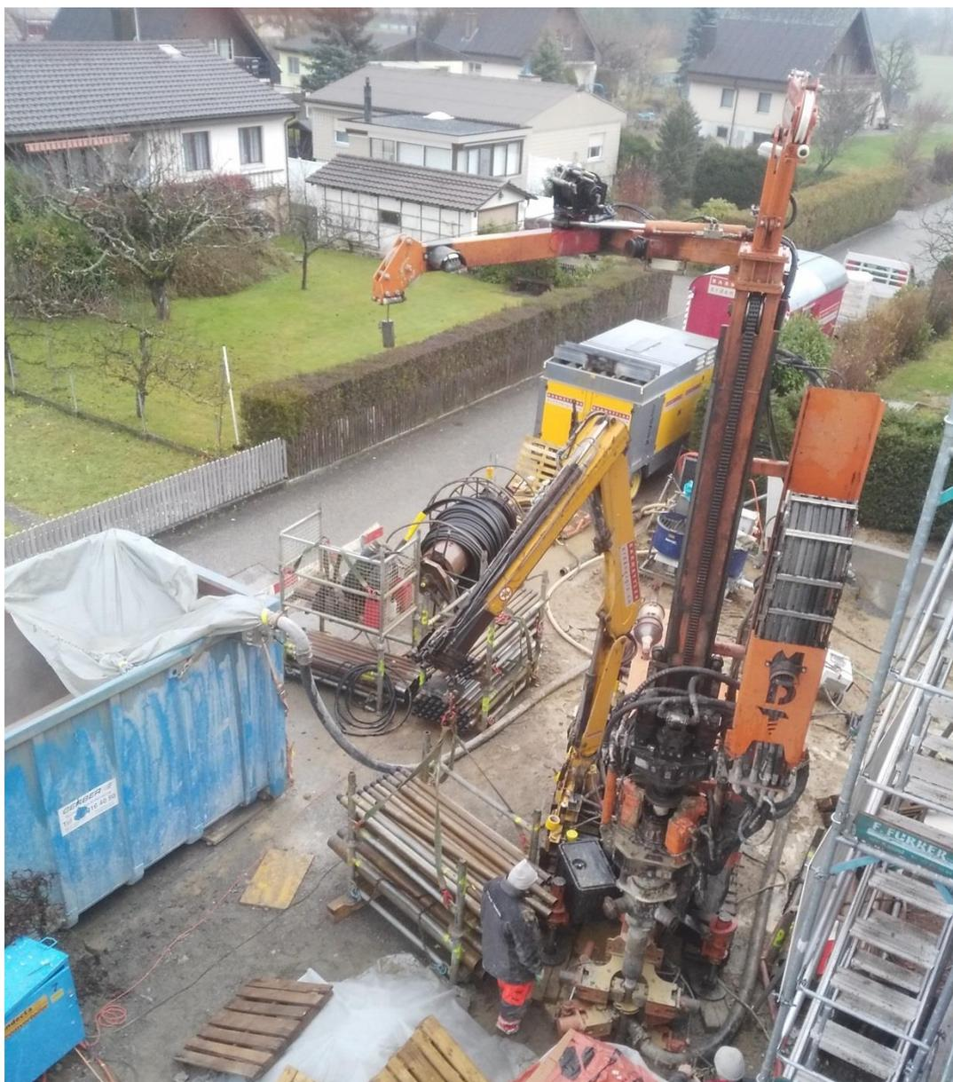
Figura 5 Trapano con attrezzatura lungo la strada (discarica di fanghi, tubi, compressore, camionetta dei lavoratori, furgone)
