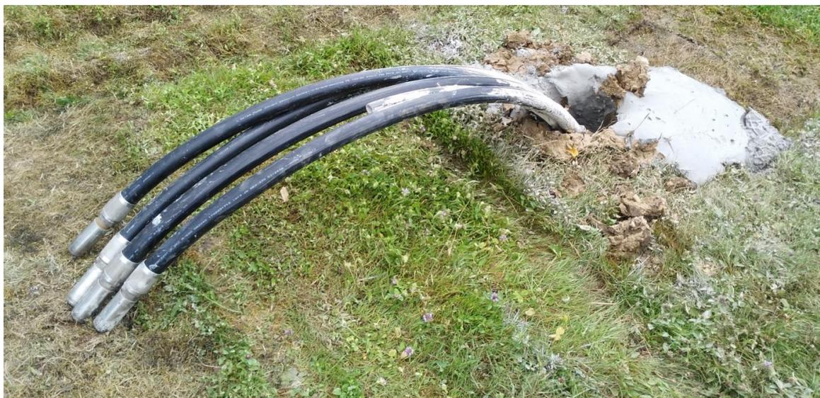
Figura 9 Le sonde rimangono a tenuta stagna dopo il riempimento. Il livello del cemento di riempimento si è abbassato nel foro che deve essere riempito di nuovo
