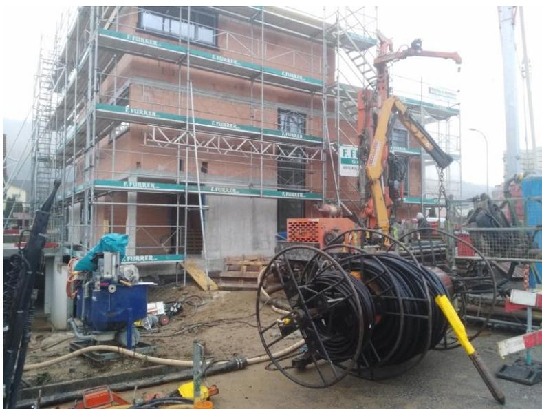
Figura 6 Tubi della sonda geotermica con tubo di riempimento sulla bobina. Al piede della sonda, è attaccato un peso.
