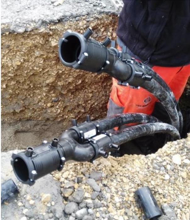
Figura 13 I due tubi di entrata e uscita delle sonde geotermiche sono collegati mediante tubi a Y e collegati al collettore mediante tubi PE50.
