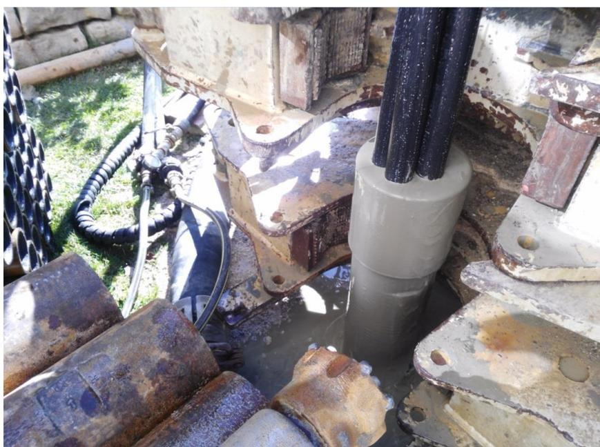
Figura 8 Riempimento completo del foro. Il cemento viene alla luce
