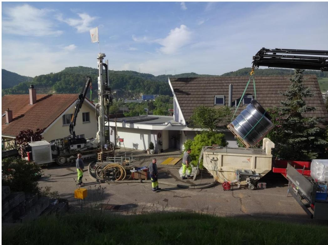
Figura 4 Piattaforma di perforazione con trapano, benna di raccolta dei fanghi, sonda, pompa di miscelazione, tubi della sonda e camion
