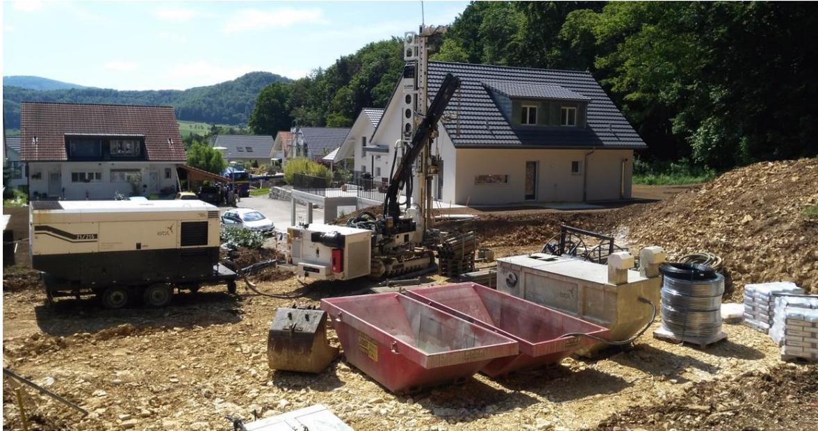
Figura 2 Impianto di perforazione, compressore, benna di recupero dei fanghi, materiale di riempimento e sonda stessa
