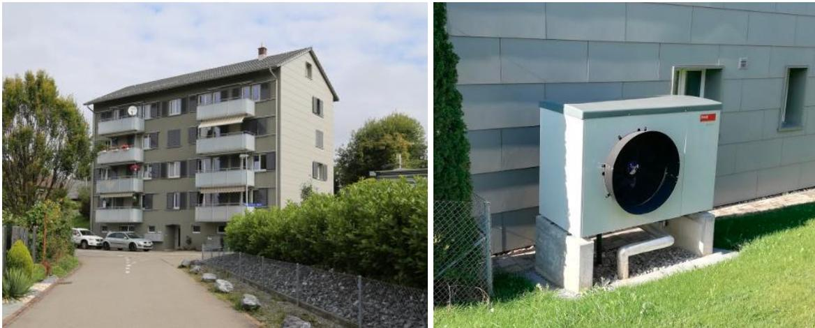
Illustration 21 : Vue du bâtiment rénové ; pompe à chaleur installée à l'extérieur sur un socle en béton, à proximité de la façade. Source : voro Immobilien.
