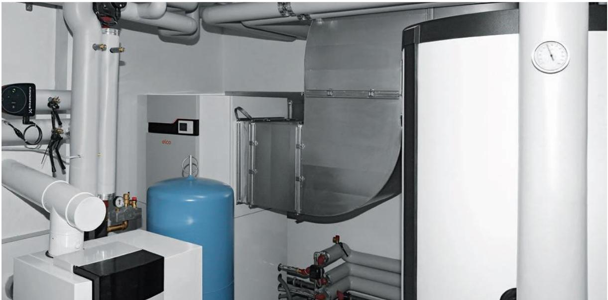
Illustration 31 : PAC implantée à l'intérieur entre la chaudière à gaz à condensation et le réservoir. Source : Elcotherm AG.
