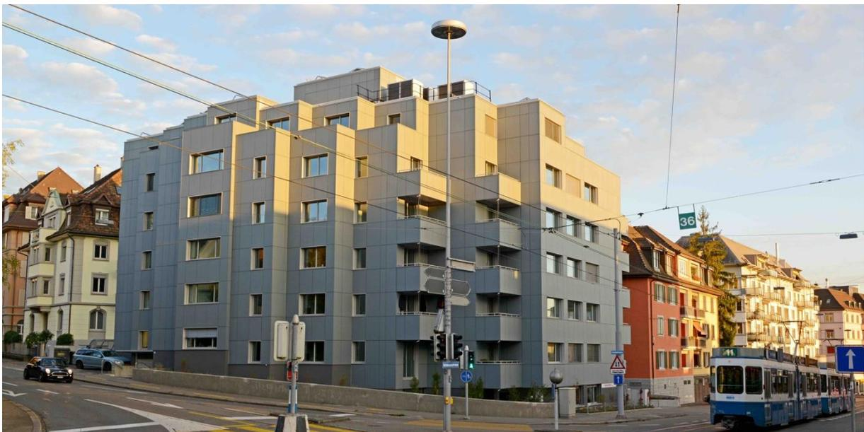
Illustration 1 : Bâtiment après rénovation, avec façade photovoltaïque et pompes à chaleur sur le toit.
