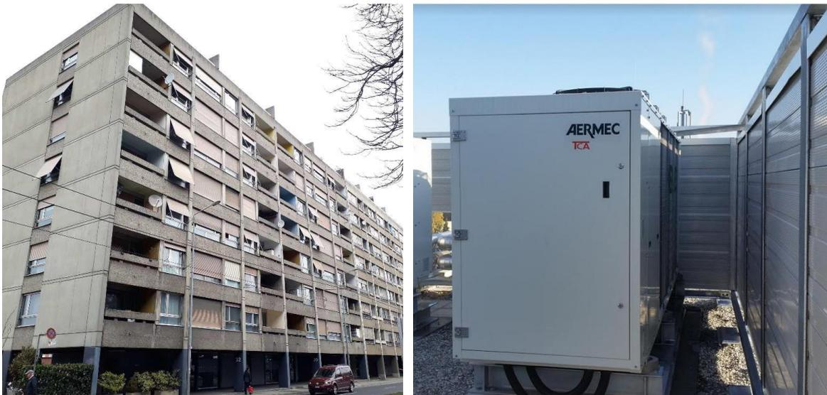
Illustration 10 : Vue du bâtiment, pompe à chaleur installée sur le toit avec enceinte antibruit. Source : SIG-éco21
