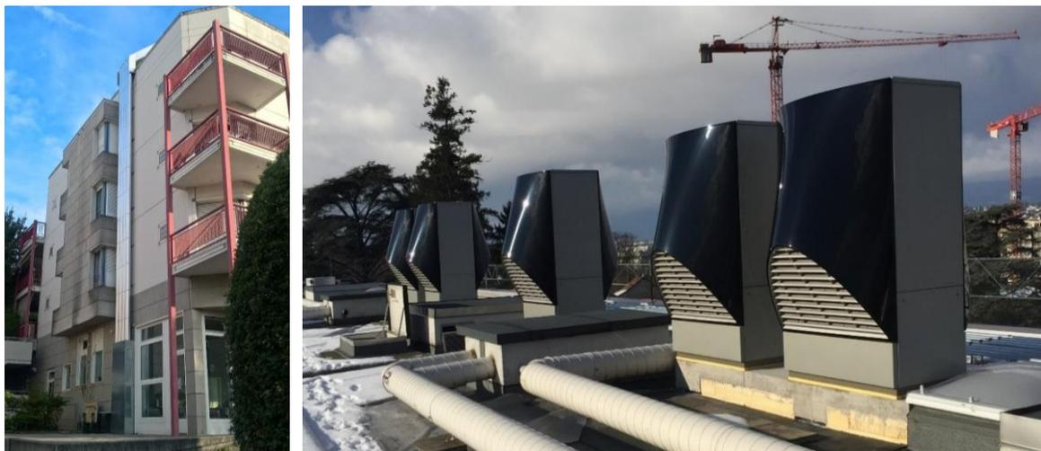
Illustration 11 : Vue de la façade avec conduites apparentes ; pompes à chaleur sur le toit. Source : SIG-éco21
