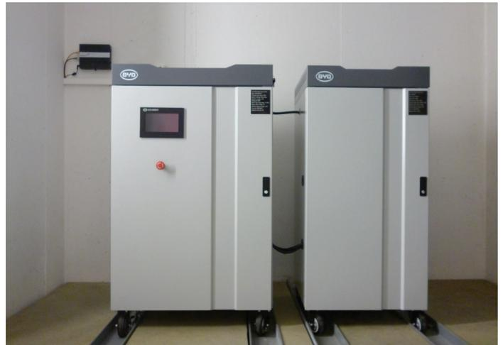
L'Azienda Elettrica Ticinese (AET) e le altre aziende elettriche coinvolte hanno utilizzato ciascuna un accumulatore stazionario con una capacità di 10 kWh. Foto: Enerti
