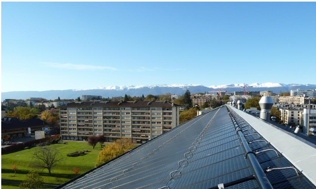
Zwei energetisch sanierte Wohnblocks in Genf können mit einer Kollektorfläche von 1680 m<sup>2</sup> über 80 % des Energiebedarfs für Heizung und Brauchwasser decken. Foto: Energie Solaire SA
