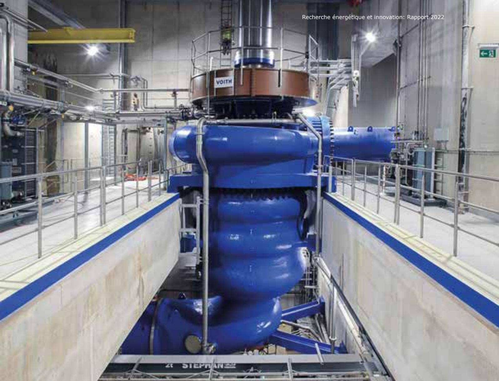
Les centrales de pompage-turbinage peuvent compenser les fluctuations du réseau électrique. Pour ce faire, elles utilisent l'électricité excédentaire pour pomper de l'eau dans le lac de retenue ou combler les goulets d'étranglement en turbinant l'eau stockée. La centrale de Veytaux étudie actuellement comment optimiser cette compensation. (Source : Forces Motrices Hongrin-Léman SA (FMHL)/ David Picard AG)
