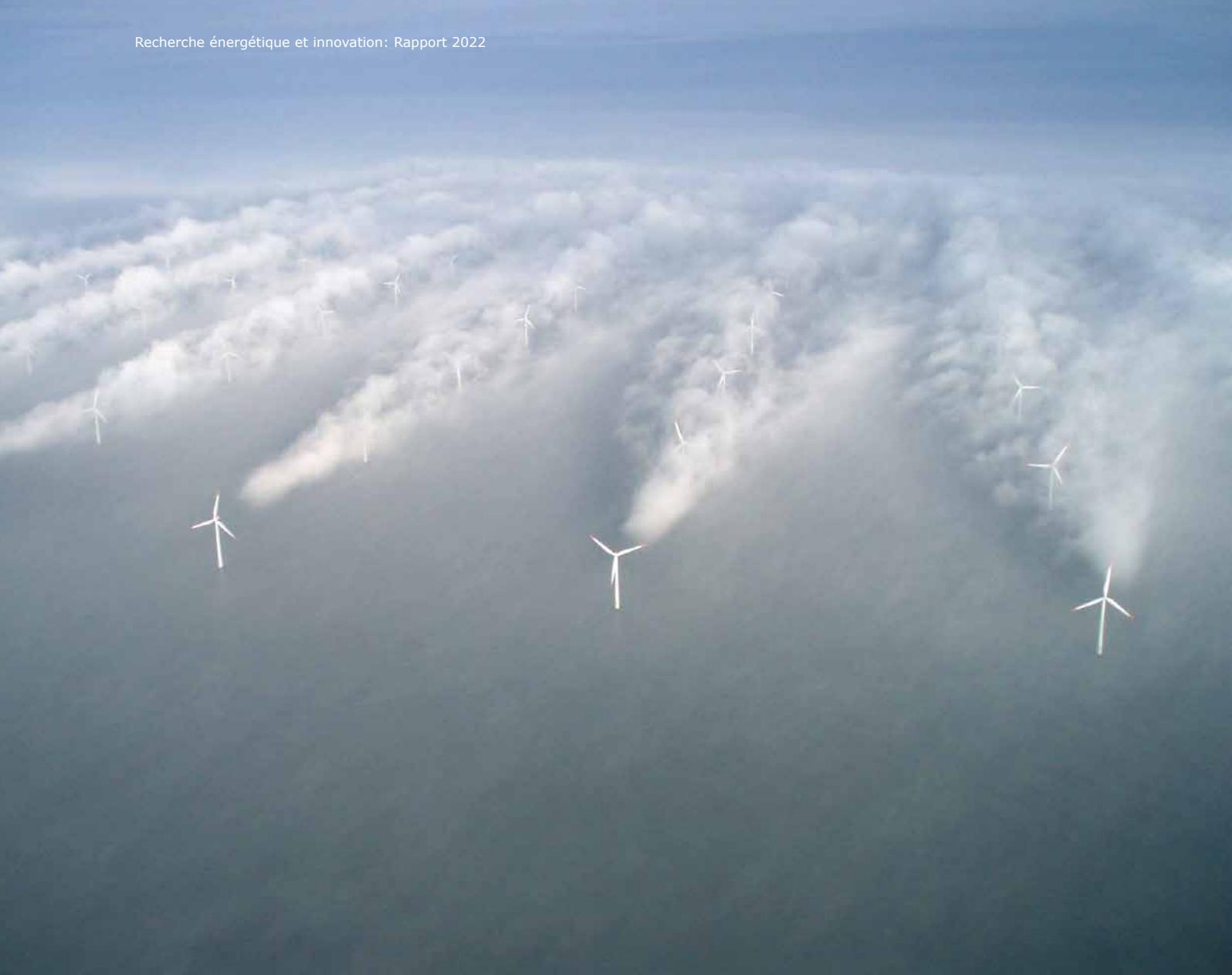
Cette image du parc éolien offshore «Horns Rev 1» au large des côtes danoises montre les circulations d'air (tourbillons) qui peuvent se produire derrière une éolienne (source: Horns Rev 1 owned by Vattenfall, photographe Christian Steiness).
