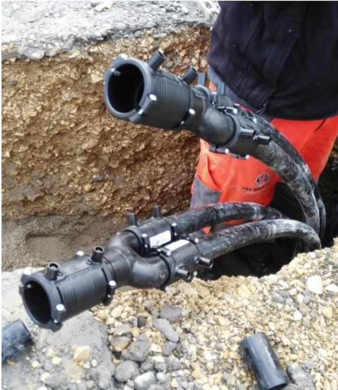
Abbildung 11 Vor- und Rückläufe der EWS werden mittels Hosenstücken zusammengefasst und mittels einer PE50 Leitung an den Verteiler(-schacht) geführt
