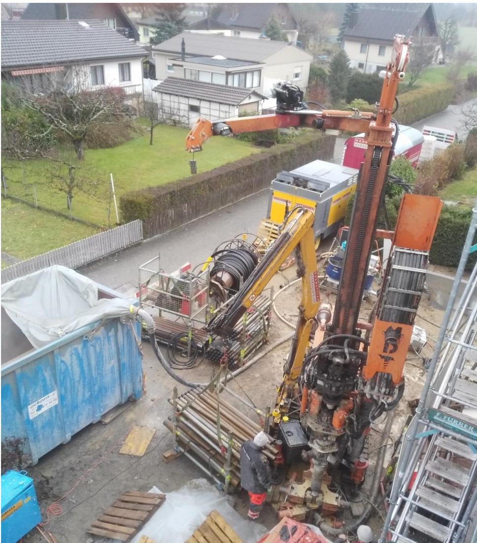
Abbildung 5 Bohrgerät mit Ausrüstung entlang der Strasse (Schlammulde, Schläuche, Kompressor, Mannschaftswagen, Lieferwagen)
