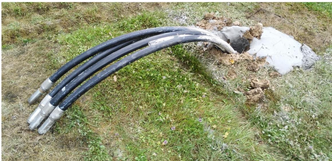
Abbildung 9 Sonden bleiben nach Einbringen der Hinterfüllung druckdicht verschlossen. die Hinterfüllung in der Bohrung ist etwas nachgesackt und muss später wieder aufgefüllt werden.
