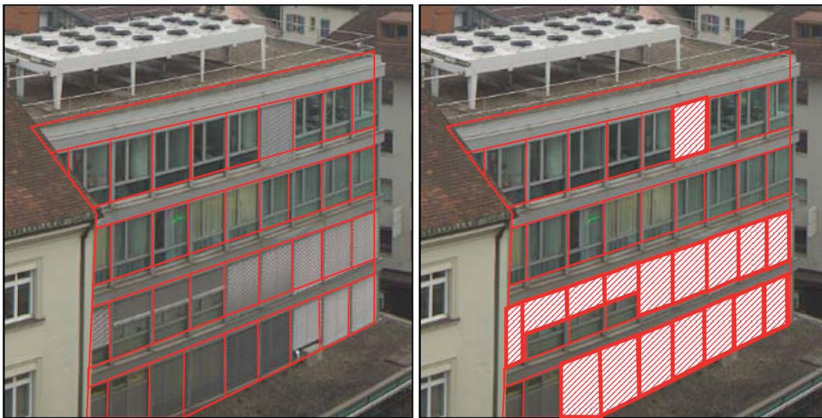
Dans le bâtiment de bureau, 15,5 des 36 fenêtres sont protégées par des stores à lamelles (c'est-à-dire 43% de la surface vitrée). Les stores à lamelles réduisent l'apport de chaleur dans le bâtiment de bureaux de 43%. Pour le formuler autrement: le facteur d'ombre de la protection solaire est de 0.57. À partir de plusieurs centaines de telles valeurs individuelles, les scientifiques de Lemon Consult ont déduit la «protection solaire avec facteur d'ombre pondéré». Photos: Lemon Consult
