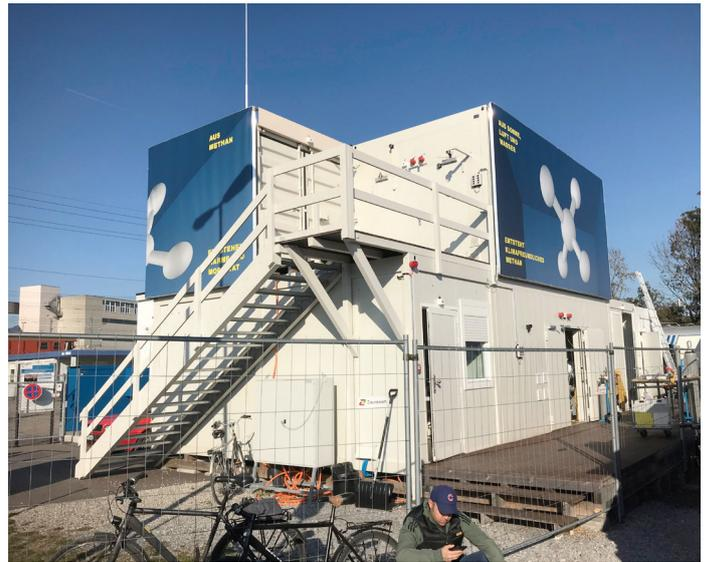
Mit dieser Anlage erforscht die Hochschule für Technik Rapperswil die katalytische Methanisierung. Die Effizienz der Umwandlung von Strom in das Gas Methan («Power-to-Methan») soll entscheidend erhöht werden, um so eine lohnende Speicheroption für erneuerbaren Strom zu schaffen. Foto: HSR
