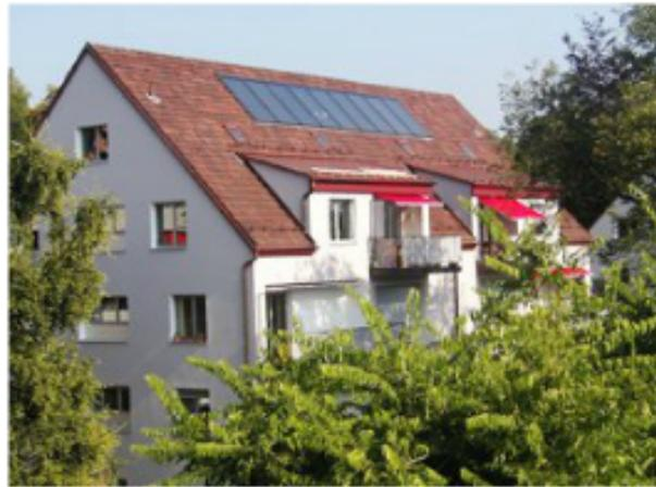
Die Sonnenenergie hat sich für die Warmwasserbereitung und zur Heizungsunterstützung bestätigt. Günstige Dachausrichtung vorausgesetzt lassen sich integrierte Kollektoren wählen. (Bild: GBZ Zürich)
