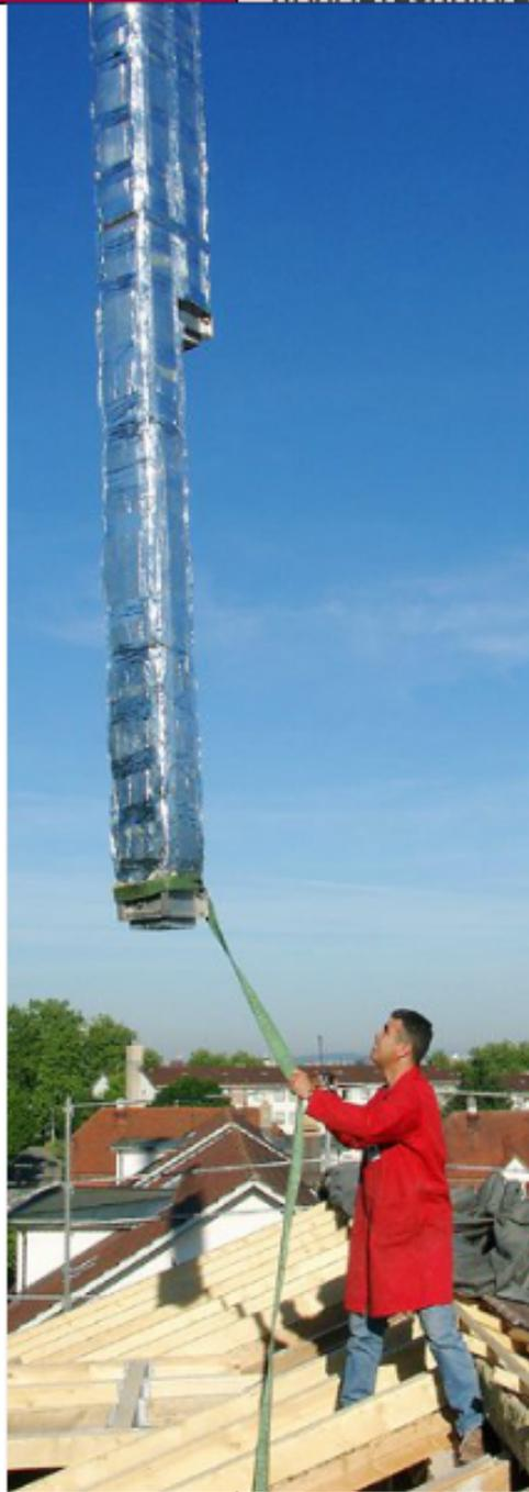
Für den Energieaustausch zwischen Abwärmeströmen (Wohnung/Feuerung) und der Frischluftzufuhr kann ein einbaubares Sammelkanalsystem eingesetzt werden. Dieser Aluminium-Kanal bietet vor allem bei Sanierungen von Mehrfamilienhäusern bautechnische Vorzüge. (Bild: Friap AG)
